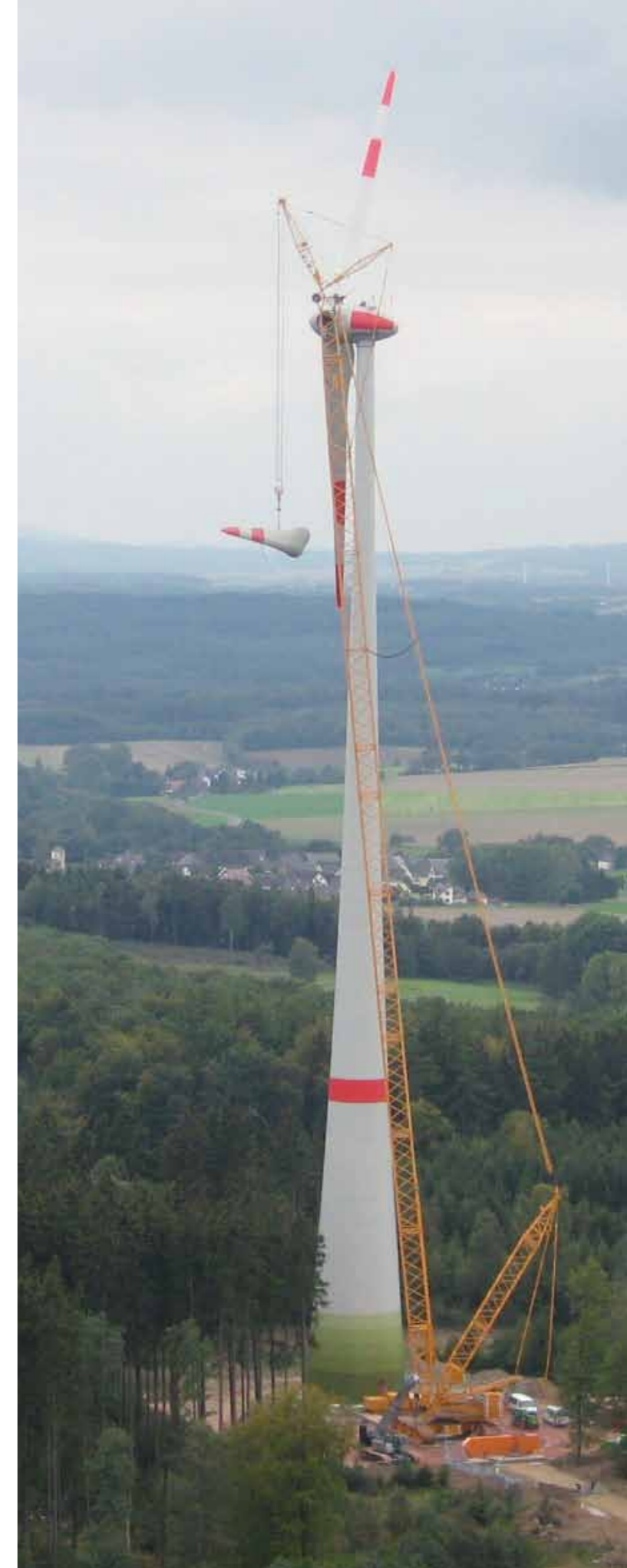
Platzsparendes Aufbauverfahren: Im Windpark Kirchberg setzte ENERCON die Einzelblattmontage ein.
