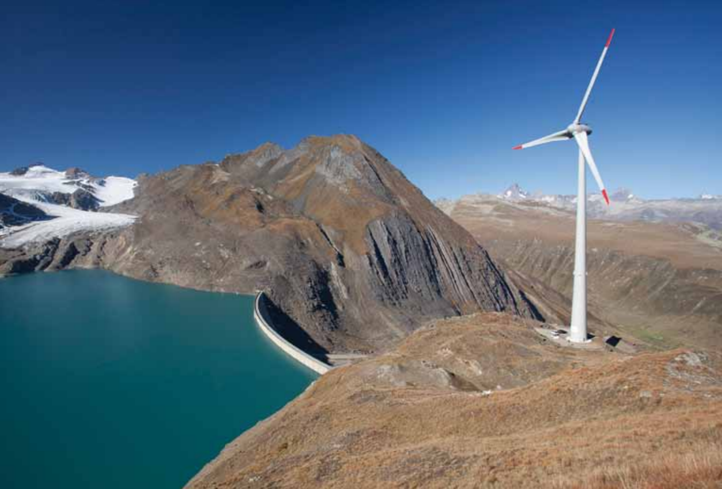
Die ENERCON E-70 am Gries steht auf rund 2.500 Metern Höhe.
