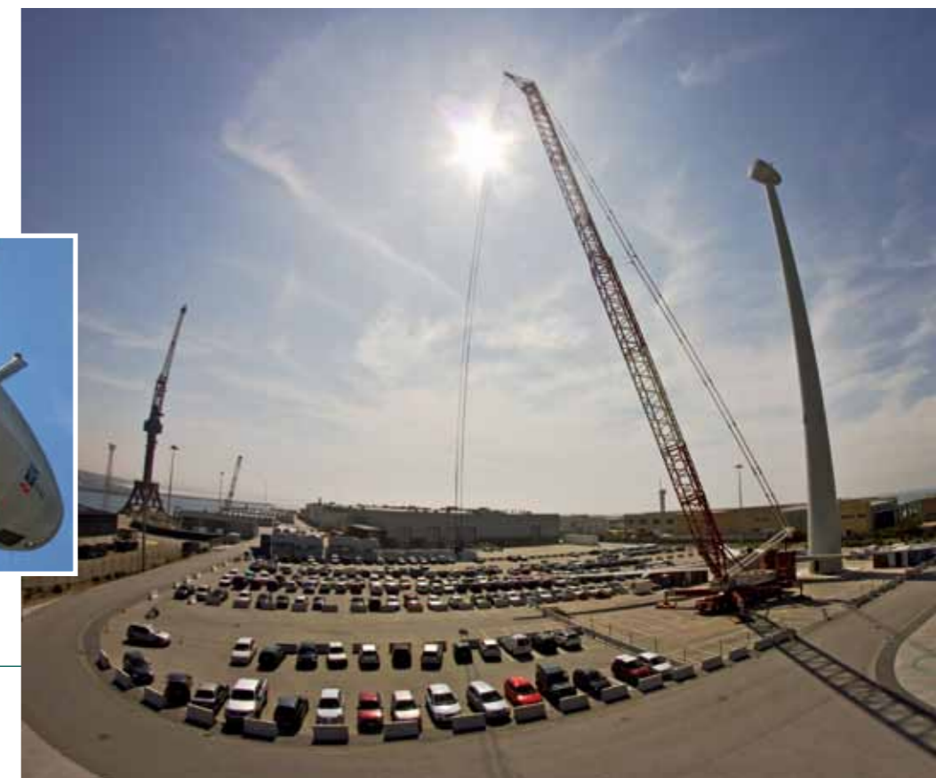
Aufbau der E-82 in Praia Norte in Viana do Castelo.
