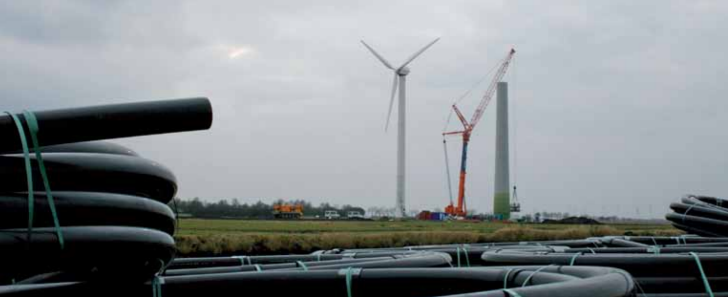
Eines der ersten Erneuerungsprojekte mit ENERCON E-101: Im Windpark Holtgaste bei Leer in Ostfriesland sollen fünf dieser Maschinen zehn alte Tacke TW 600 ersetzen.
