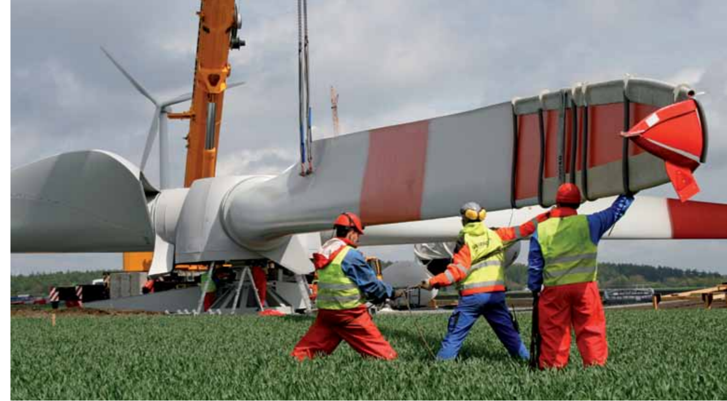
Vormontage der Rotornabe einer ENERCON E-82 Windenergieanlage im Windpark Holbel.
