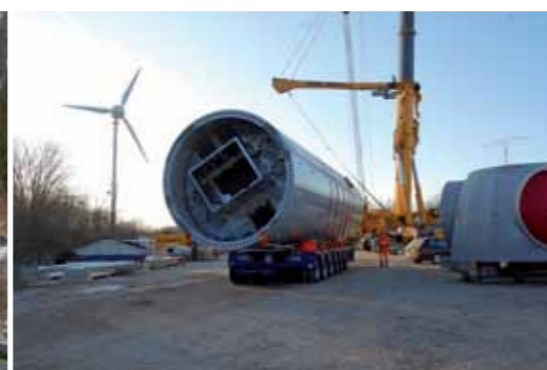
Alt und neu für kurze Zeit am selben Standort: ENERCON E-40 und E-82 auf dem «Hollandskopf» (Bild links). Rotorblatttransport mit dem Alpin-Gestell (mitte). Bild rechts: Ankunft eines Turmsegments per Selbstfahrer auf der Baustelle.
