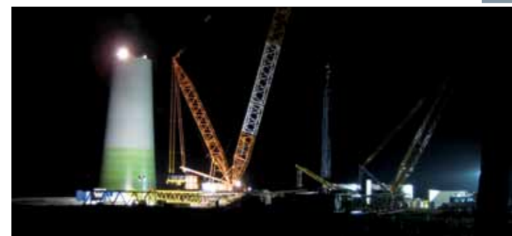
Aufbau bei Tag und bei Nacht: Auf der E-126 Baustelle bei Medemblik wurde rund um die Uhr gearbeitet.
