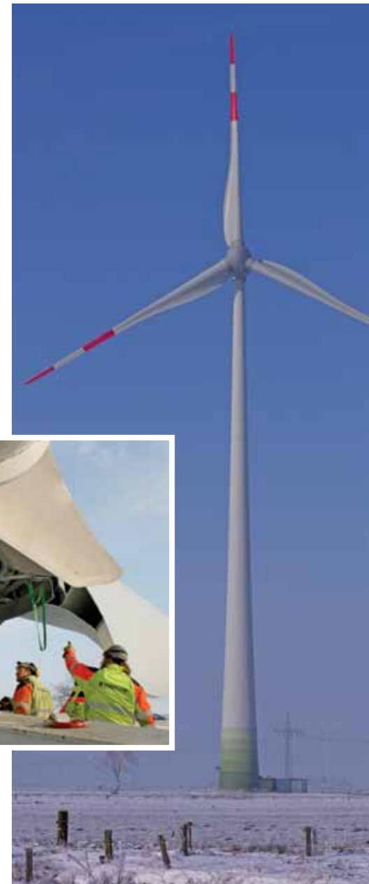
Verladung der für den E-92 Prototyp bestimmten Rotorblätter am Logistikplatz in Aurich (links). Letzte Vorbereitungen für den Nabenzug (mitte). Bild rechts: Der E-92 Prototyp ist errichtet.
