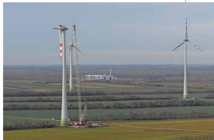
ENERCONs Beton-turmwerk in Zurndorf grenzt an ein Windfeld mit E-101/3 MW Windenergieanlagen.
