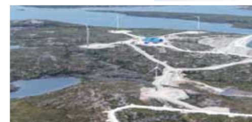
E-70 Windenergieanlagen auf dem Gelände der Diavik-Mine. Bild rechts: Montage einer E-70.
