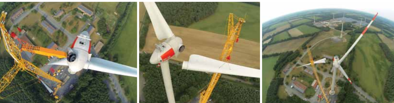
E-101 Aufbau im Bioenergiepark Saerbeck.
