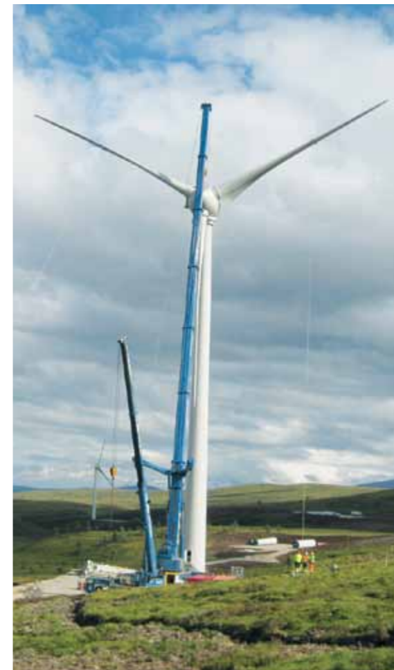
Installation einer ENERCON E-70 in der Berry Burn Wind Farm.
