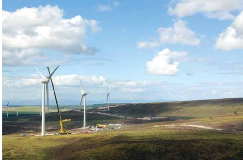
Anlagenmontage in der Berry Burn Wind Farm.
