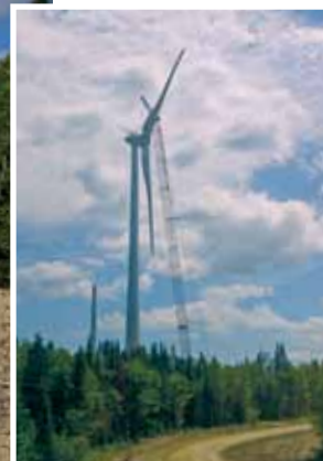
E-92 Baustelle im Windpark Vents du Kempt/Québec.
