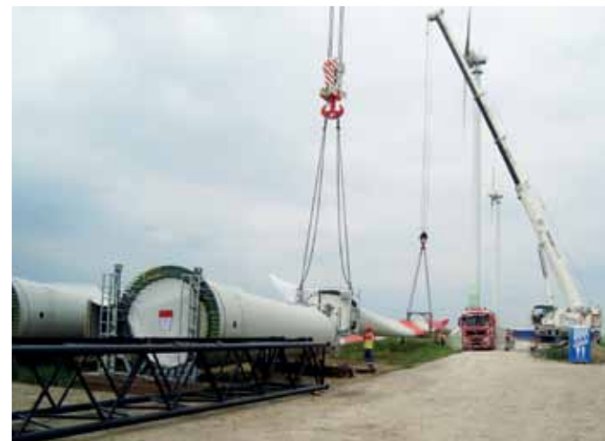
E-115 Aufbau im Windpark Feldheim VII.
