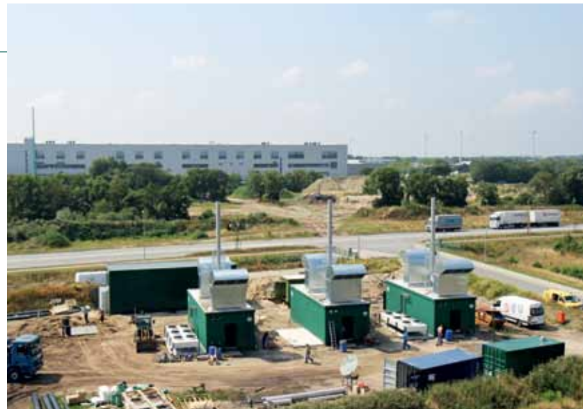
Baustelle der Blockheizkraftwerke. Im Hintergrund ENERCONs Rotorblattfertigung KTA.
