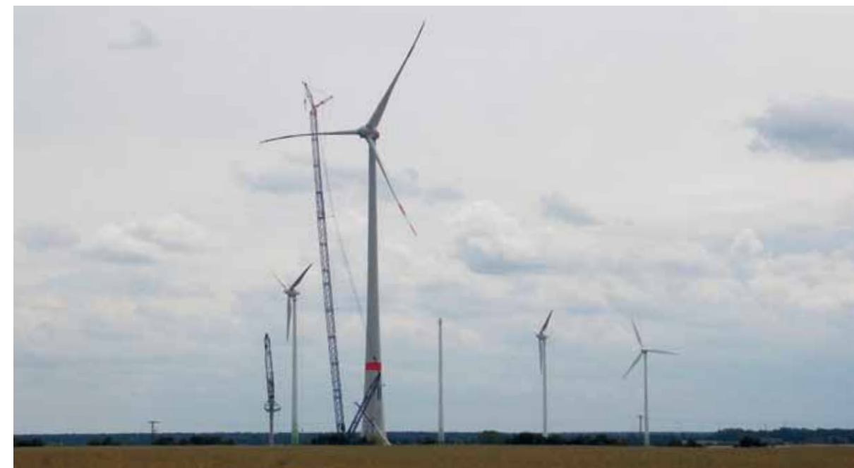
Erste Serienmaschine errichtet: E-115 Baustelle in Feldheim/Brandenburg.
