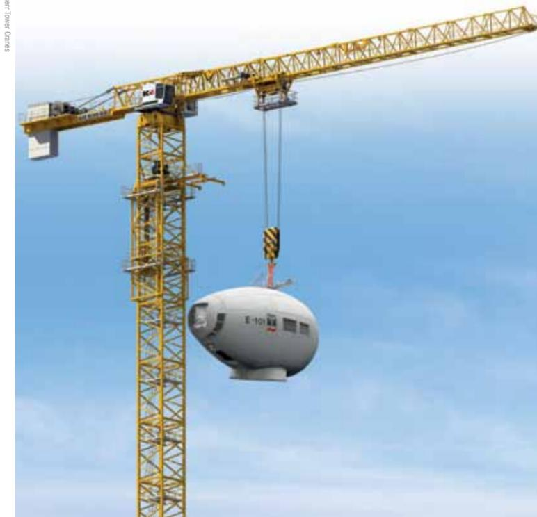
ENERCON wird an eingeschränkten Standorten beim E-101 Aufbau künftig einen Turmdrehkran von Liebherr einsetzen. Der 1000 EC-B125 wurde vom Hersteller auf ENERCONs spezielle Anforderungen hin konfiguriert.
