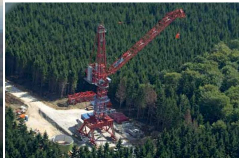
Pilotprojekt für den Anlagenaufbau mit Hilfe eines Turmdrehkrans: Windpark Seibersbach/Dörrebach mit 5 x E-101/3 MW.
