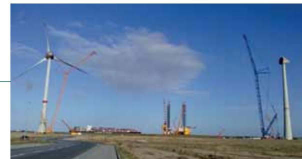
Demontagearbeiten im Testfeld Cuxhaven.
