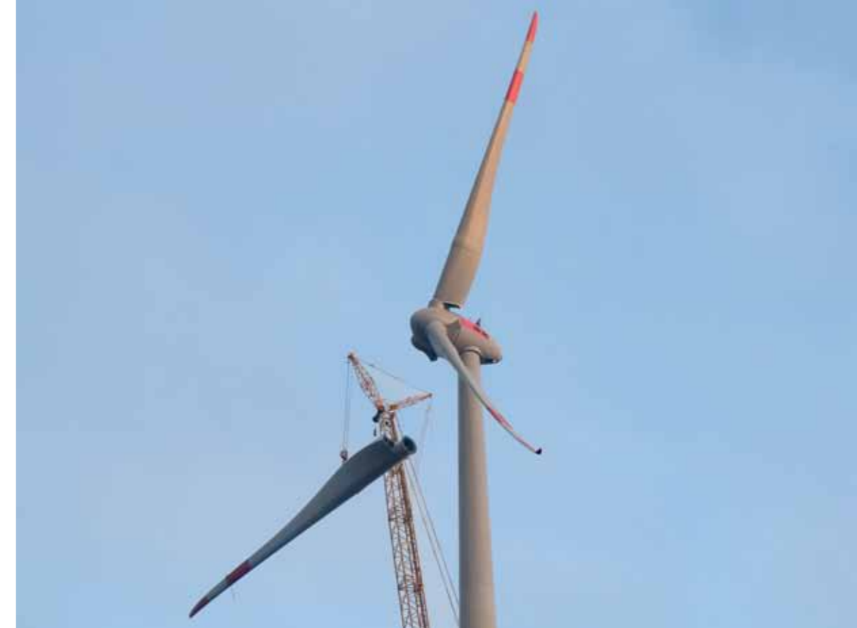
Blattmontage beim E-115 Prototyp in Lengerich.
