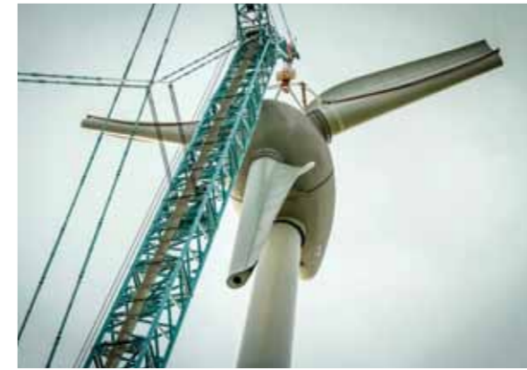
Nabenzug an einer E-126 in Neuharlingersiel.
