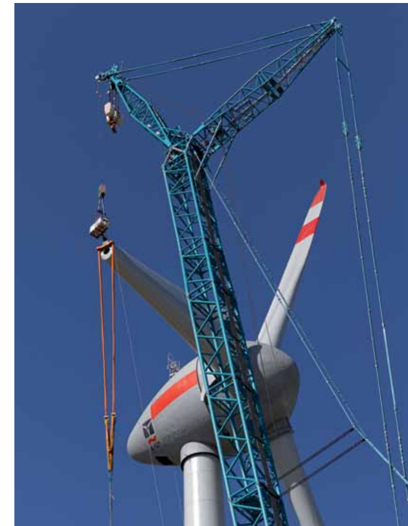
Rotorblattmontage an einer ENERCON E-126 im Windpark WKA.
