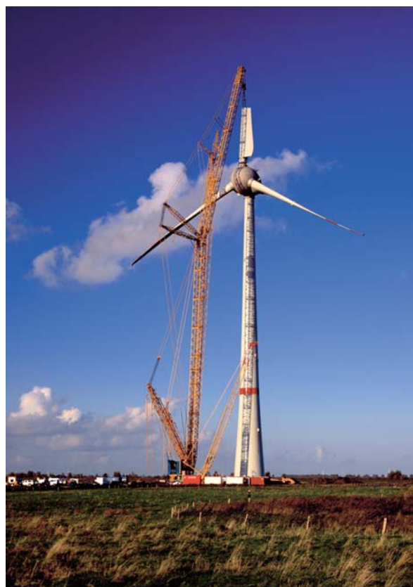
Montage des Stahlsegments des dritten Rotorblatts.
