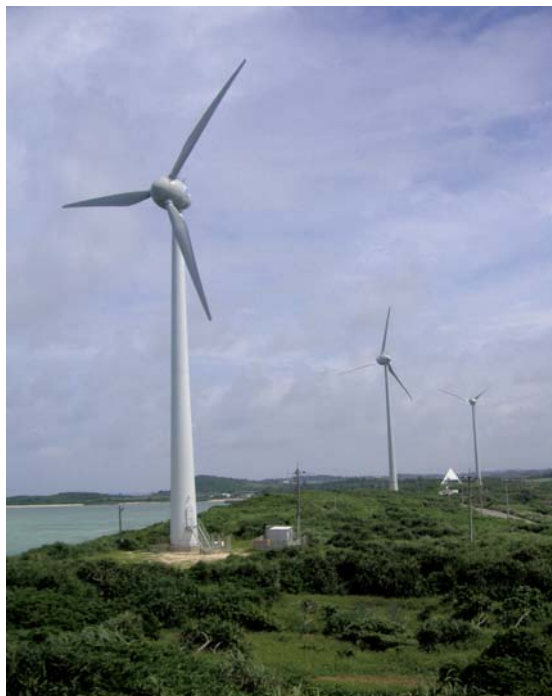
Karimata auf Miyako: erneuerte E-40 und zwei neue E-44 Turbinen.
