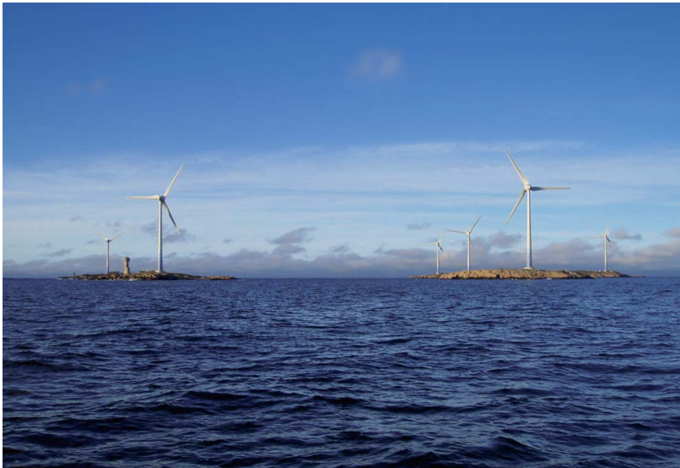
Mit einer Durchschnittsgeschwindigkeit von 9,4 m/s (in 65 m Nabenhöhe), ist Båtskär ein idealer Windstandort.
