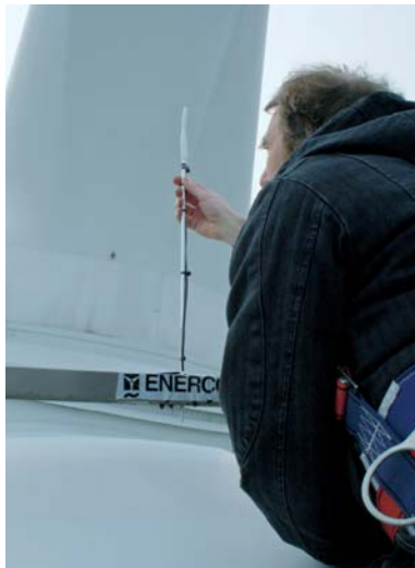
Ausrichtung der Antenne auf einer E-70.
